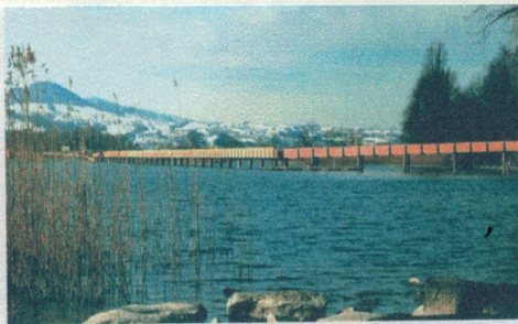
Eröffnung des 841 m langen Holzstegs von Rapperswil SG nach Hurden SZ 6. April 2001
